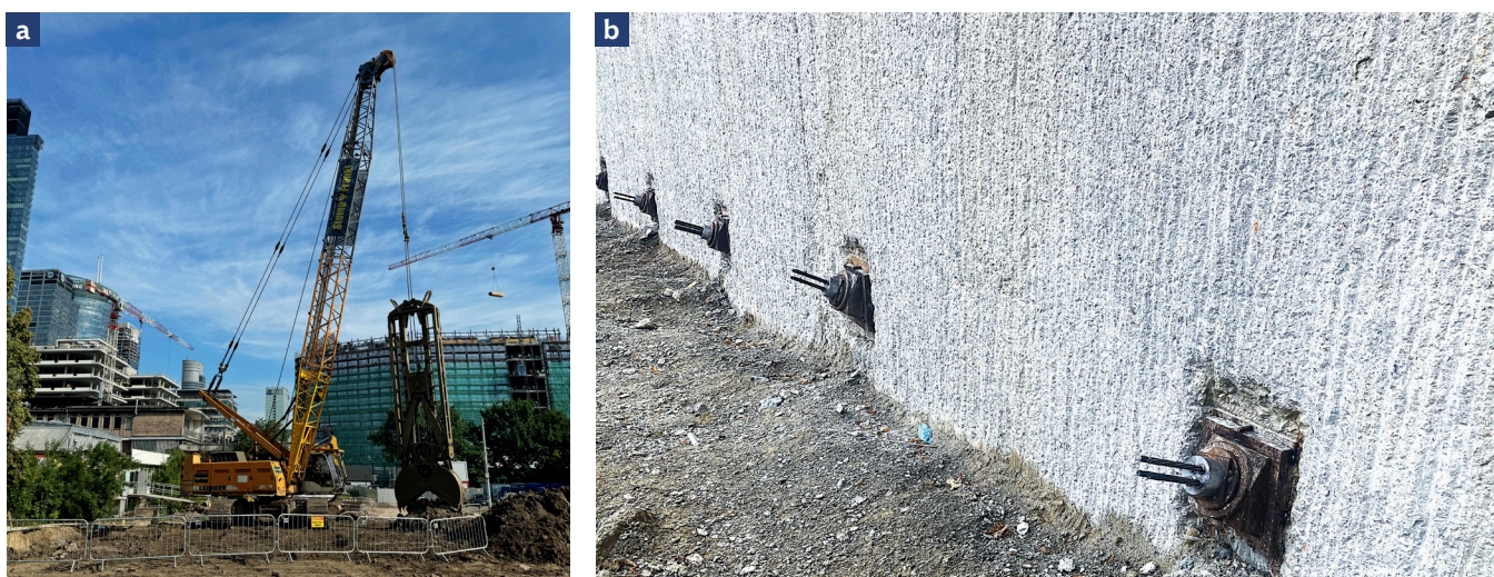
Ryc. 5. Budynek G przy ul. Towarowej 22: a – głębenie ścian szczelinowych, b – głowica kotwy wielobufawowej [2], fot. Stump Franki Sp. z o.o.
