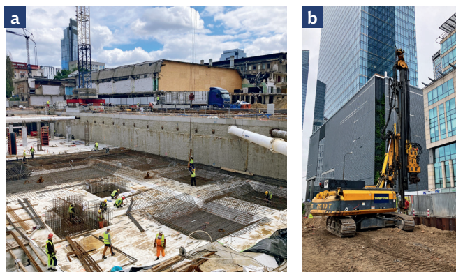
Ryc. 3. Budynek B przy ul. Towarowej 22: a – kotwiona i rozpięta ściana szczelinowa, b – montaż tymczasowych grodzic stalowych [2], fot. Stump Franki Sp. z o.o.
